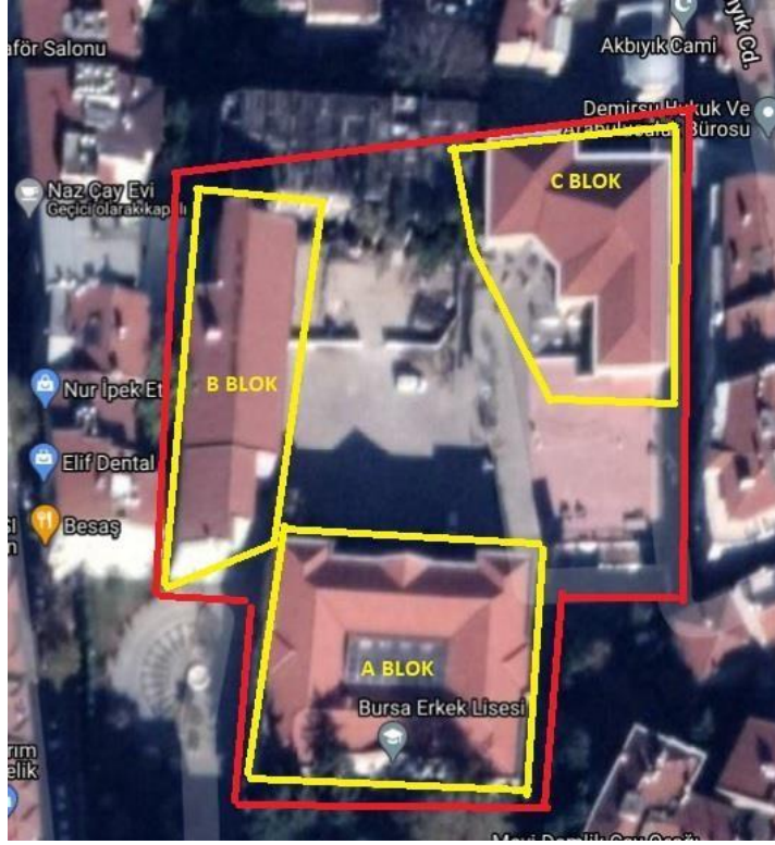
Şekil 3: Bursa Erkek Lisesi Üstten Görünümü
